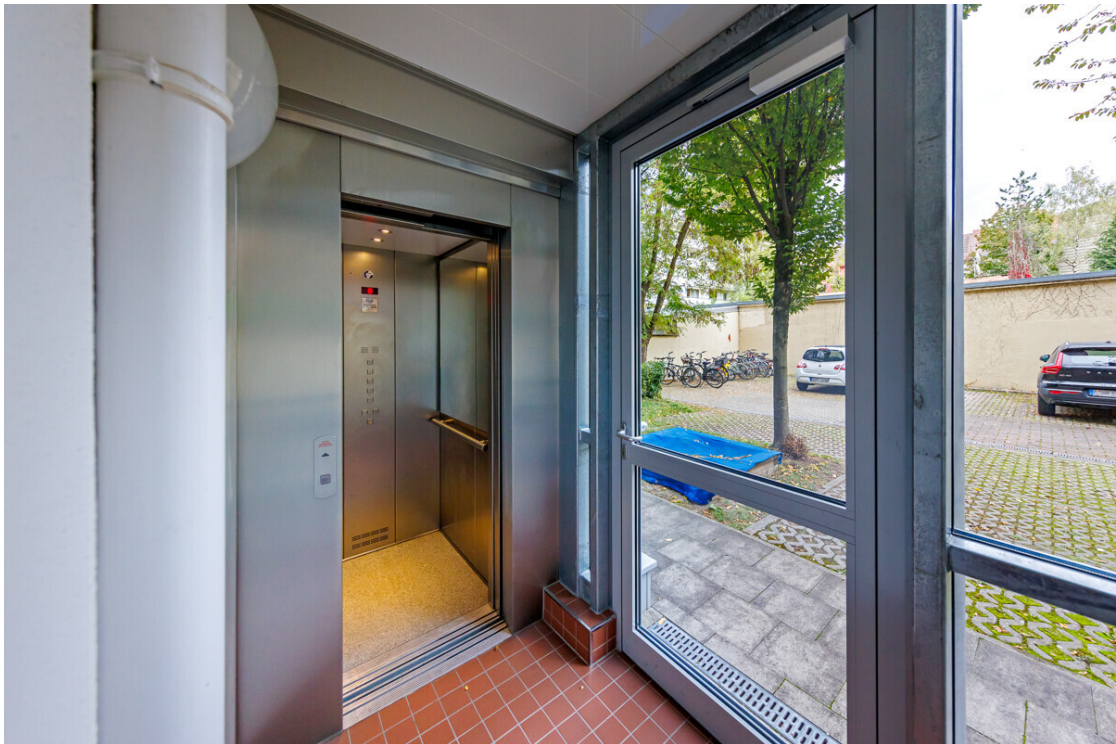
Aufzug im Haus
